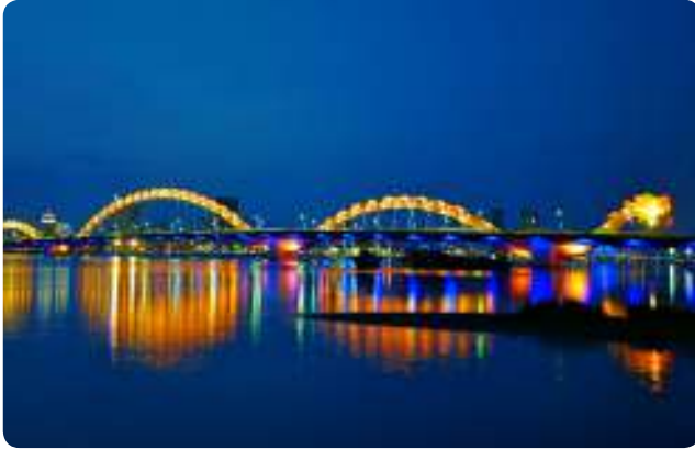
Hệ thống cáp trên cầu Cable system on bridges
